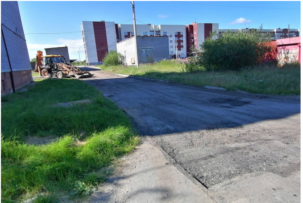
1. Снятие деформированного слоя асфальтового покрытия
