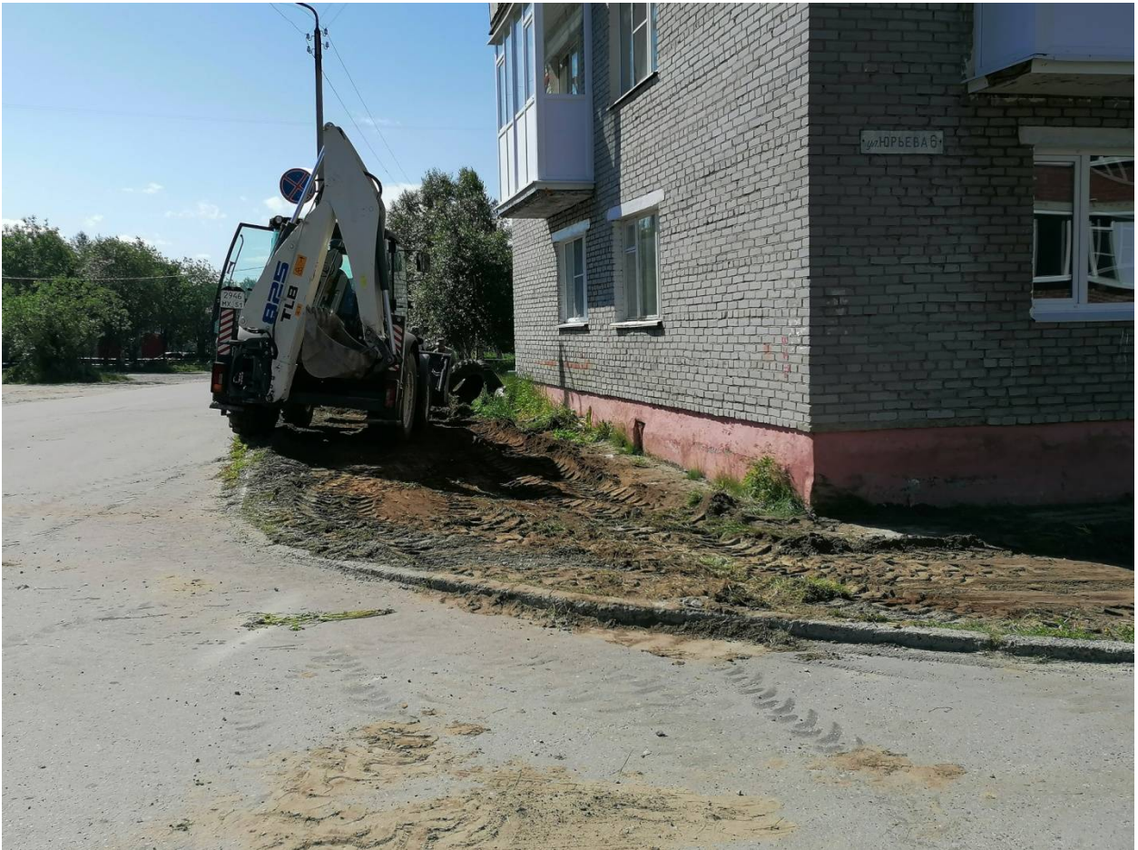
1.4.Снятие верхнего слоя грунта
