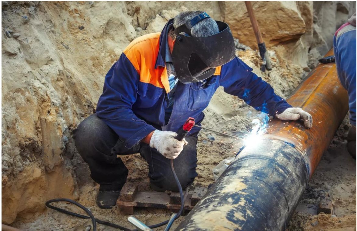
Замена участка теплотрассы РСОШ (ул.Победы, 16а) – 348,5 тыс.рублей
