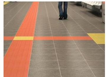
Уличные плитки монтируются в тротуар таким образом, чтобы они не являлись препятствием для пешеходов. Внутри помещений используют как встраиваемые, так и наклеивающиеся на половое покрытие плитки или отдельные тактильные элементы.
