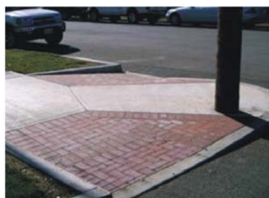
Рисунок 22 – Пример пандусов с бортиками
