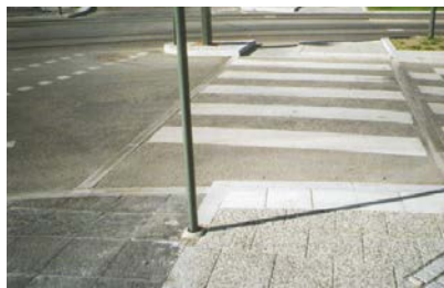
Рисунок 24– Пример выполнения пандусов по краю пешеходного перехода
